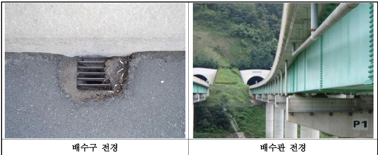
【사진 3.3.19】 배수구 및 배수관 전경(부산)
