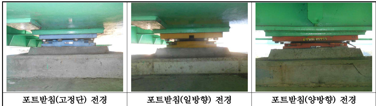
【사진 3.2.12】 교량받침 전경(대구)
