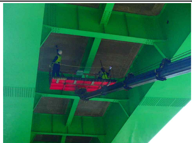
고소점검차를 이용한 조사
