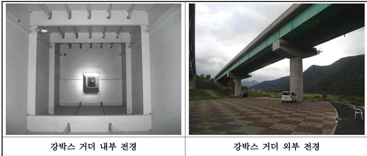
【사진 3.2.3】 강박스 거더 전경(대구)
