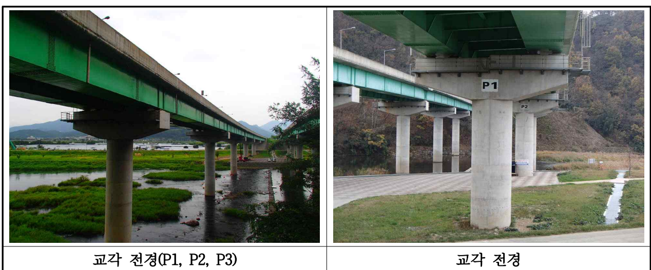
【사진 3.3.9】 교각 전경(부산)
