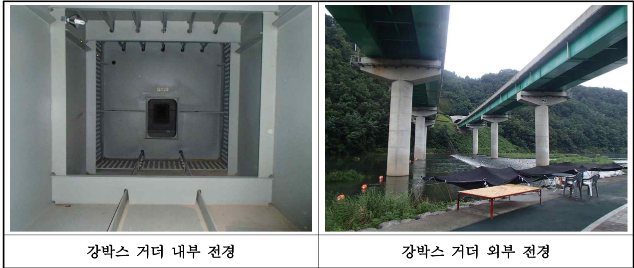
【사진 3.3.3】 강박스 거더 전경(부산)
