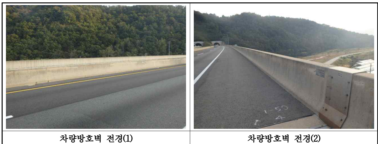
【사진 3.3.21】 방호벽 전경(부산)
