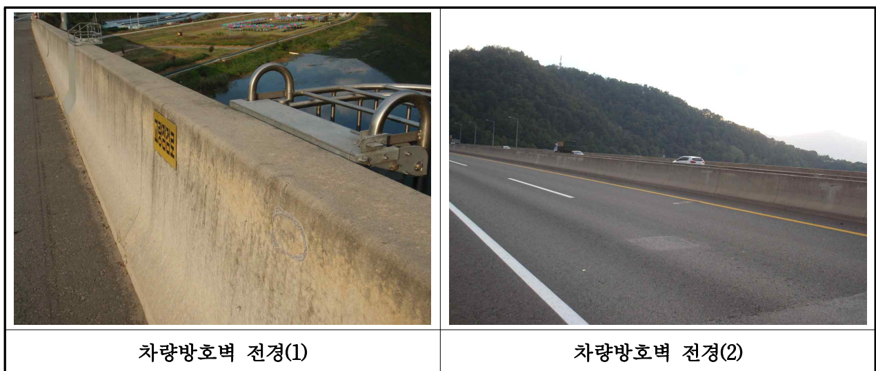
【사진 3.2.21】 방호벽 전경(대구)
