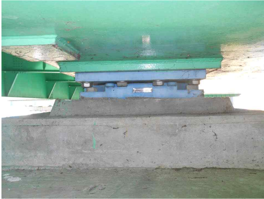
받침장치 전경 (고정단)
