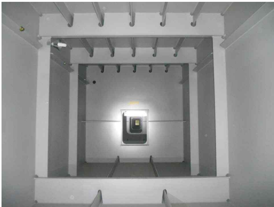
Steel Box Girder 내부 전경
