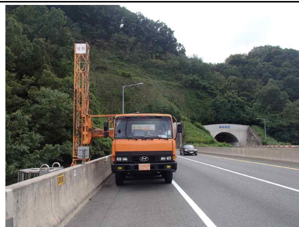
교량점검차를 이용한 조사
