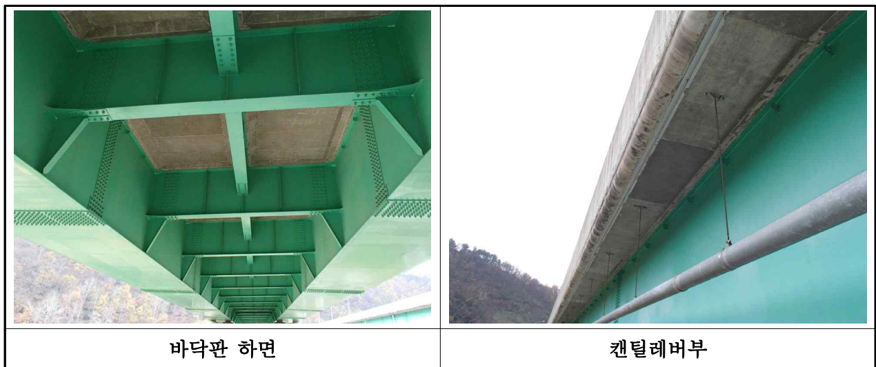
【사진 3.2.1】 바닥판 하면 전경(대구)
