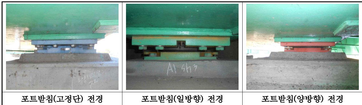
【사진 3.3.12】 교량받침 전경(부산)
