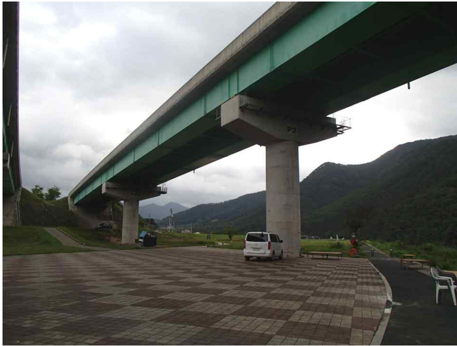
Steel Box Girder 외부 전경
