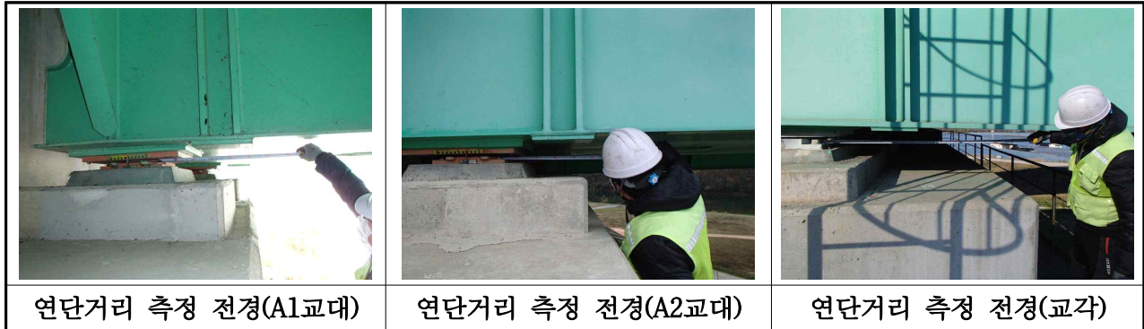
【사진 3.2.14】 연단거리 측정 전경
