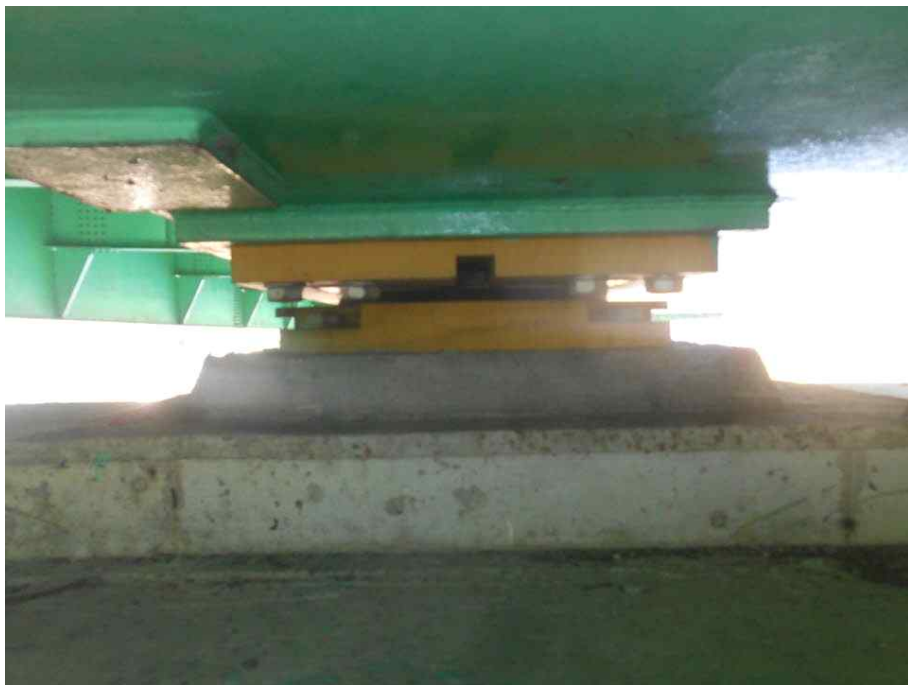
받침장치 전경 (가동단)
