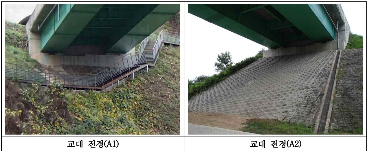
【사진 3.3.7】 교대 전경(부산)
