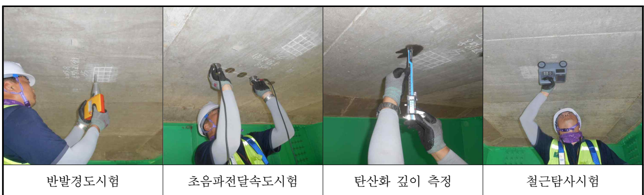
【사진 3.4.1】 콘크리트 내구성조사 전경
